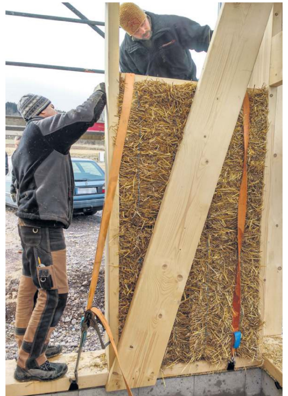
In die Holzkonstruktion werden die komprimierten Strohballen eingebaut. Foto: Steffen Dachsel
